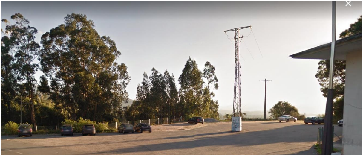
Apoio de paso aéreo subterráneo na PO-415
